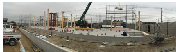
総合福祉プラザ完成予想図（写真上）と、建築工事風景（写真下）
