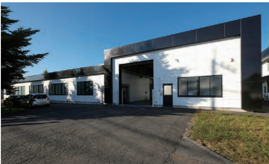
平成30年に新設した第3工場
