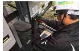
正常に発電しているか専用機器で検査をする様子
