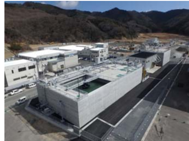
女川町水産加工団地排水処理施設整備等事業
