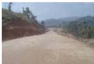
工事が進むバイパス
