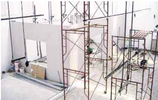
建設中の中小企業向けレンタル工場 (日系企業管理運営)
