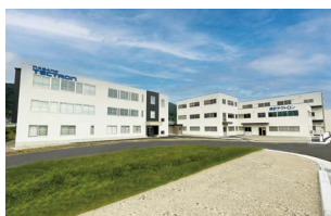
■長野テクトロン株式会社 本社
