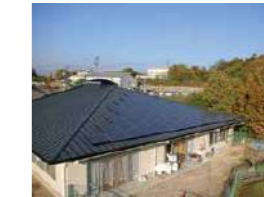
■ 太陽光発電施工
