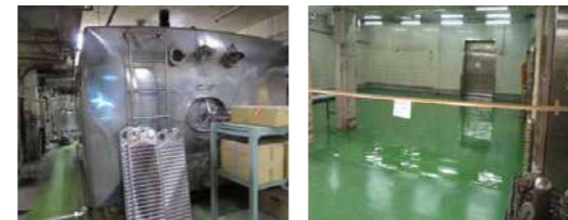
■ 未使用タンク・設備の撤去
