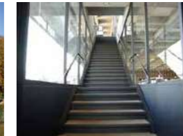
■ 窓サッシ建具施工
