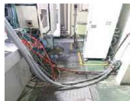
■ 改善前の生産現場
