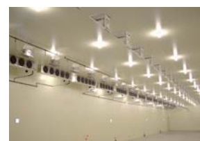
■ 施工事例 「空調換気設備」(上)、 「冷凍冷蔵設備」(下)
