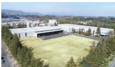
■ 三重プラント社屋外観
