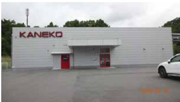
いわき工場外観
