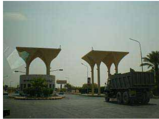
リヤド市南部にある リヤド第 2 工業団地入口
