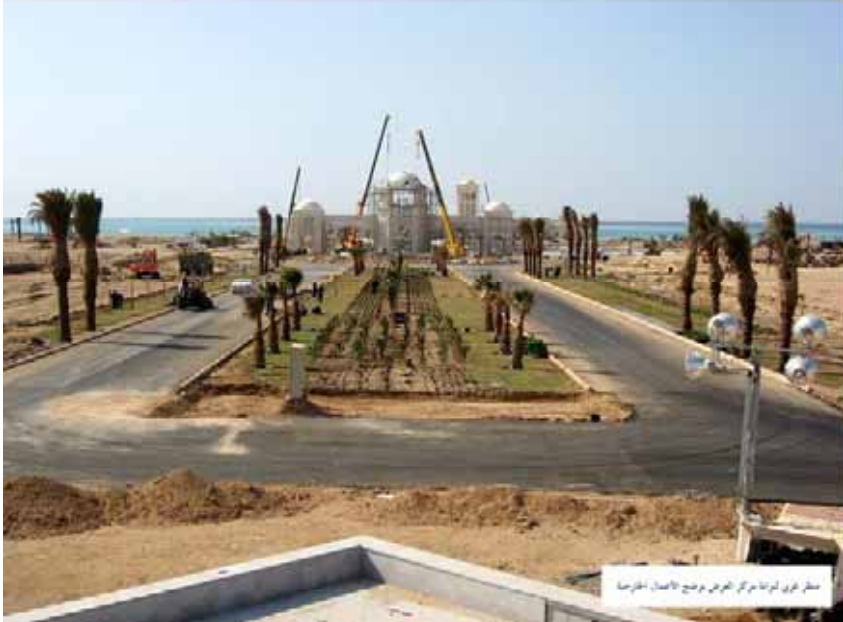
写真: 建設中のエコノミックシティ
