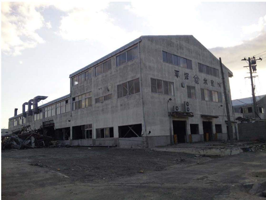
写真 2 山徳平塚水産の魚町にある工場外部
