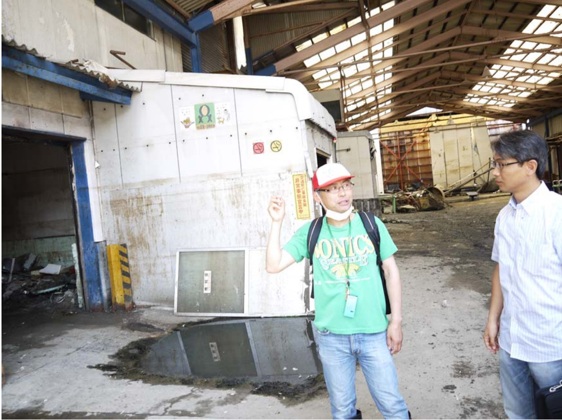
写真1 山徳平塚水産の魚町にある工場内部
