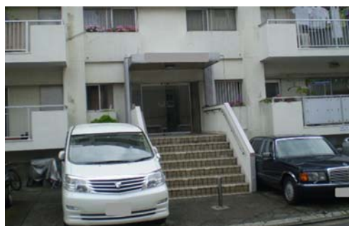
築40年のマンション（改修前）
