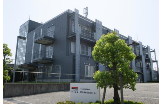
施設外観写真
