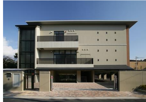
施設外観写真
