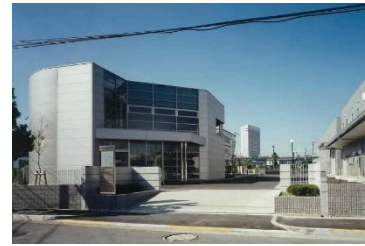
オフィス棟 外観
