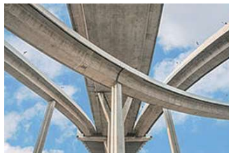
橋梁など様々な構造物に活用
