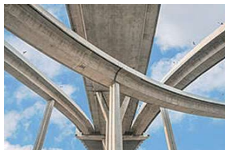
橋梁など様々な構造物に活用
