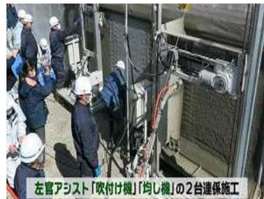
左官アシスト「吹付け機」「均し機」の2台連係施工
