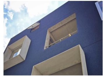
マンション窓枠の施工例
