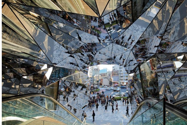
図3 ステンレス鏡面パネルの施工事例
