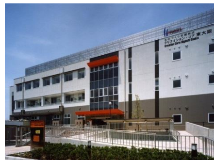
「クリエイション・コア東大阪」施設外観
