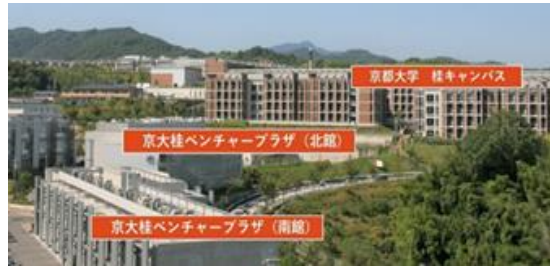
「京大桂ベンチャープラザ」外観写真
