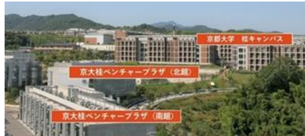
「京大桂ベンチャープラザ」外観写真
