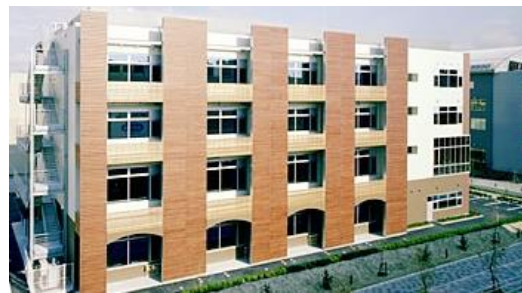
「名古屋医工連携インキュベータ」施設外観
