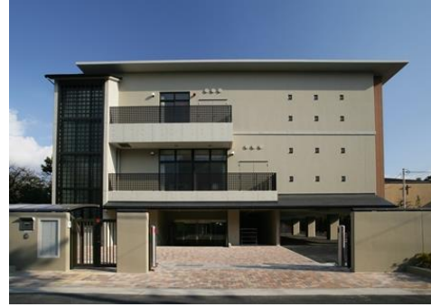
施設外観写真
