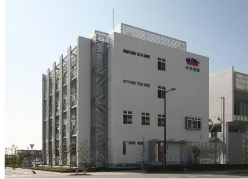
施設外観写真
