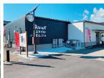
仮設店舗・事務所
