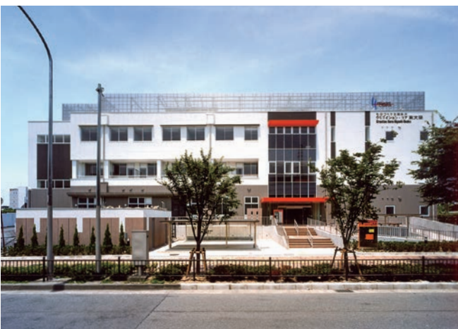
クリエイション・コア東大阪南館外観
