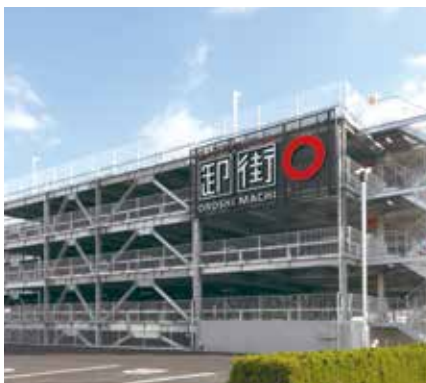
協同組合広島総合卸センターの立体駐車場
