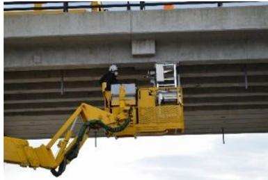
世界初！橋梁点検車に搭載可能な中性子塩分計RANS- $\mu$
