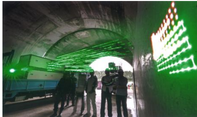
レーザー打音技術 施工総合研究所における実証実験 写真: 日本経済新聞社許可
