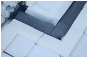
液面被覆フロート
