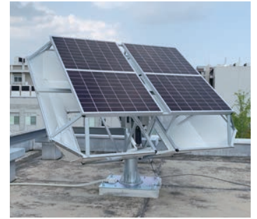
太陽光自動追尾×両面発電パネル
