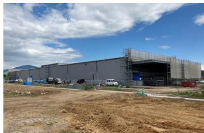
9月時点 新工場現場の様子
