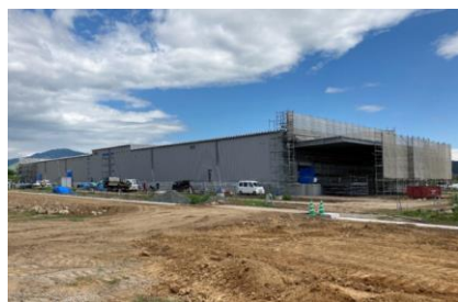
9月時点 新工場現場の様子
