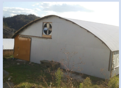
競売時にあった建物を修繕した豚舎
