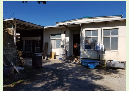
新しく完成した工房は、和紙による地域おこしを目指した町のブランディング工房としての役割も担っている
