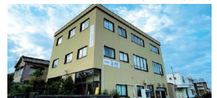
新しい社名ロゴの看板を掲げた会社外観
