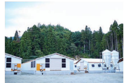
獣害や気温差などの外的影響を受けにくい近江鴨ウィンドレス鴨舎
