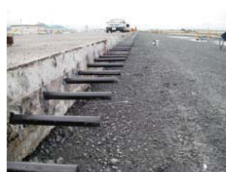
バー設置状況
