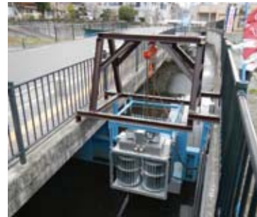
流水式小水力発電装置「ストリーム」
