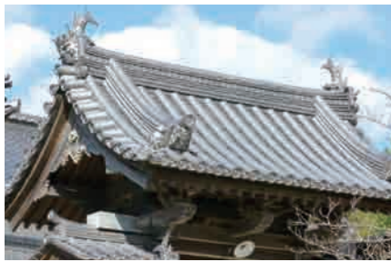
軽量瓦を使って改修が行われた屋根。価格をおさえたことも、普及促進につながっている
