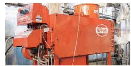
ハウス暖房機/全国で約30万台が稼働。炉内、口金、どちらに塗っても省エネ効果が見込める
