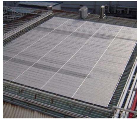
折板屋根向け外遮熱工法「ルーフェード」
