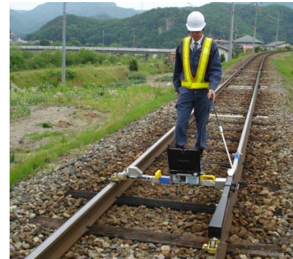
「メモレール」を使った軌道検測作業
