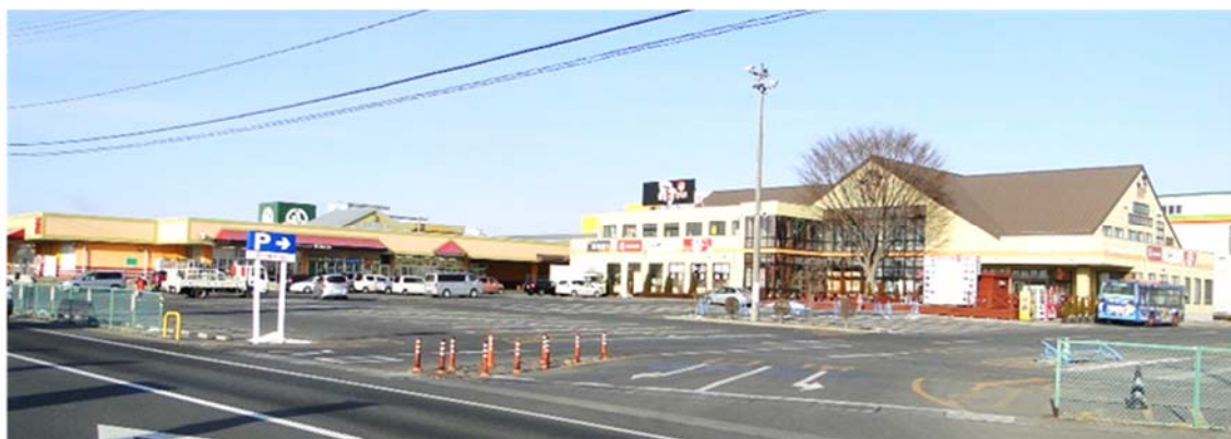
<市場棟（左側）、飲食棟（右側）>
