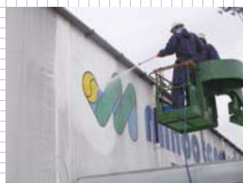
素材に合った薬剤を使用して行う「スパークルウォッシュ」
