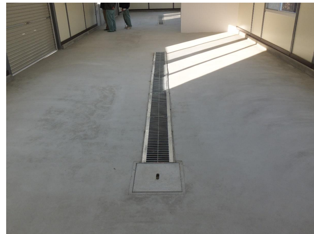
コンクリート床に設けた排水用側溝と集水枡
