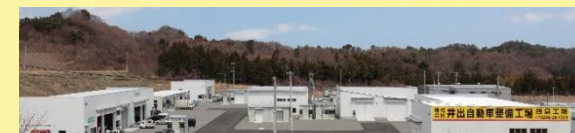
いわき市「四倉中核工業団地内仮設工場群」
