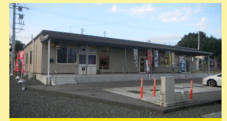
いわき市「双葉町仮設店舗」
