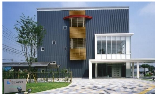
「浜松イノベーションキューブ」施設外観
