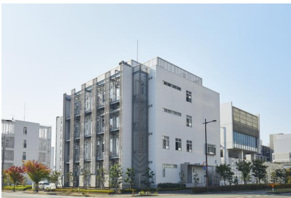
施設外観写真
