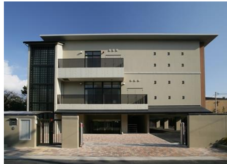
施設外観写真
