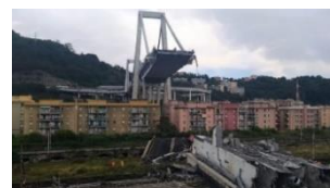
伊・ジェノバ近郊モランディ橋崩落事故 (2018.8.14) 塩分を含んだ海水が原因
