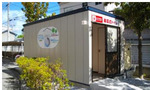
高知市立潮江中学校(学校防災) 処理槽:埋設、トイレユニット:プレハブ工法
