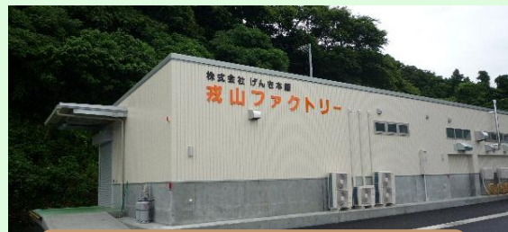
完成した宇和島の加工工場
